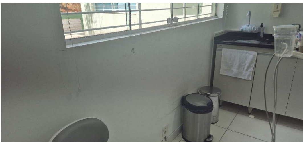
Fotos 8, 9, 10 e 11: Figura 5: Arrumar patologias da superfície – retirar reboco, e refazer. Aplicar massa corrida e posteriormente as pinturas.
