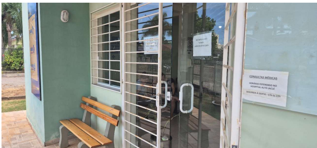
Foto 8: Retirar grades, lixar e pintar e após pintura predial recolocar.
