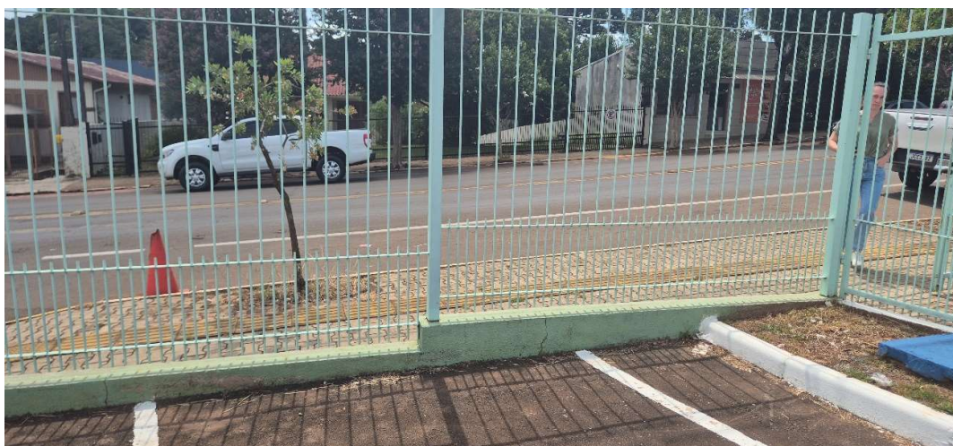
Fotos 8, 9, 10 e 11: Figura 5: Arrumar patologias da superfície – retirar reboco, e refazer. Aplicar massa corrida e posteriormente as pinturas.
