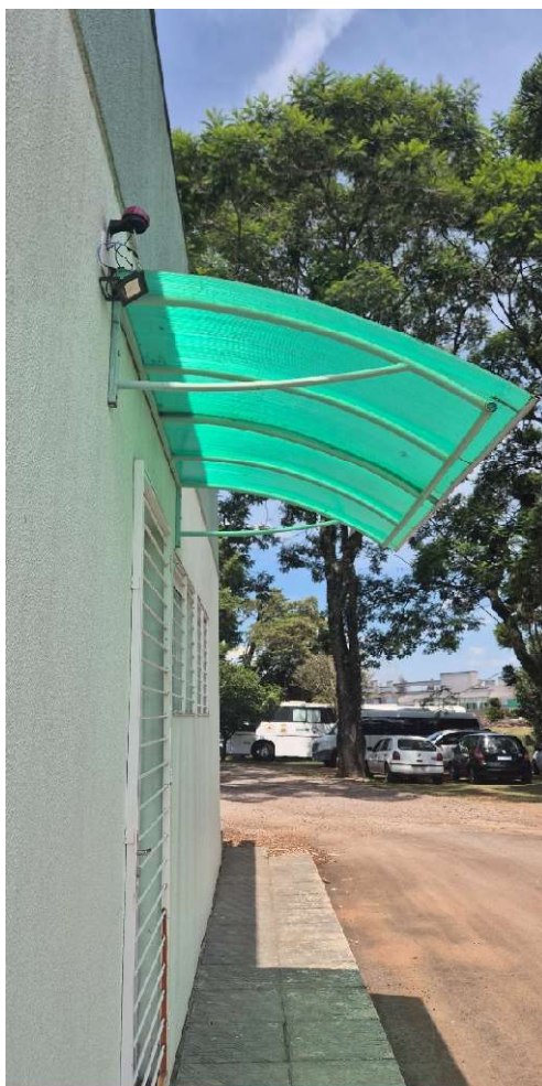
Foto 5: Retirar toldos na fachada frontal e lateral para lavar, pintar estrutura metálica e após pintura predial recolocar.
