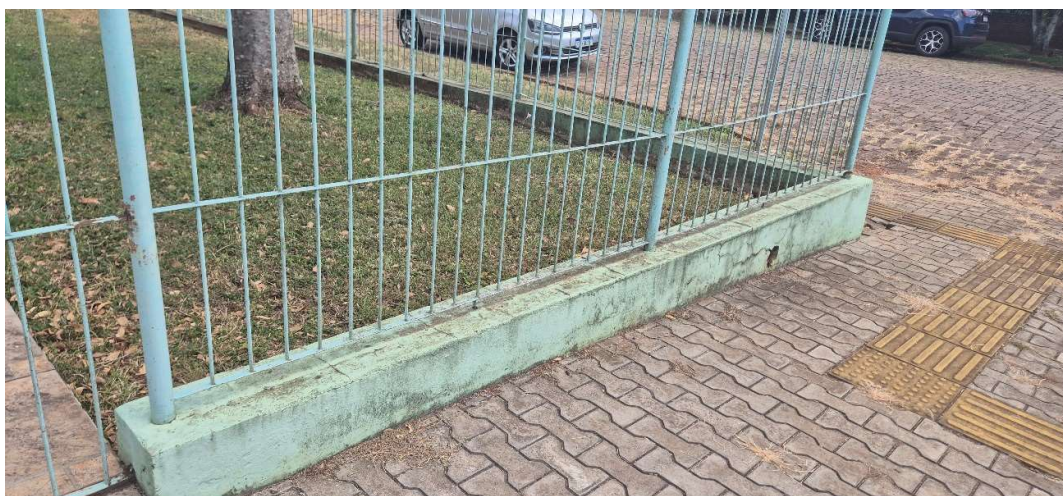
Fotos 14 e 15: Vista da subestação, do muro e grade.
