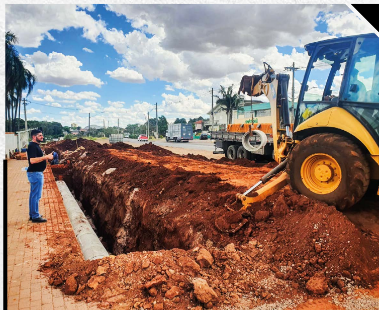
Obras seguem em execução
