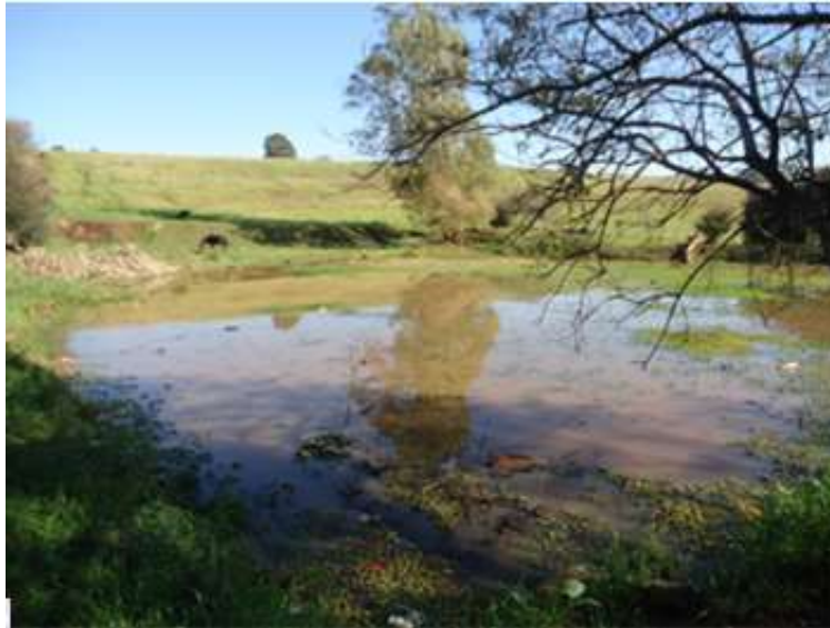
Figura 46 - Lagoa de tratamento escavada em solo e ponto de lançamento em curso hídrico referente ao sistema de esgoto junto a COHAB
