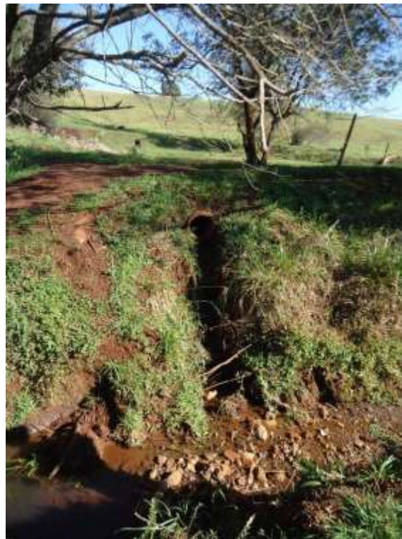
Figura 47 - Lagoa de tratamento escavada em solo e ponto de lançamento em curso hídrico referente ao sistema de esgoto junto a COHAB
