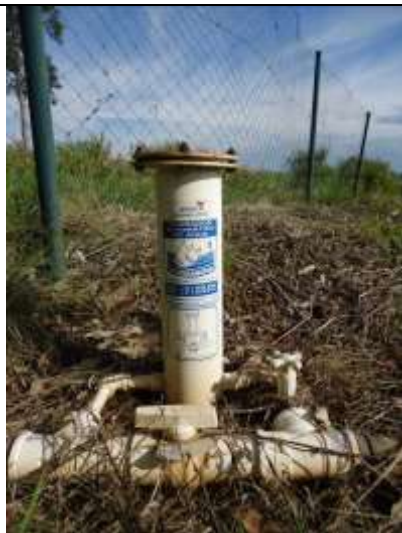
Figura 34 - Tratamento no poço denominado de Mauro Kissmann
