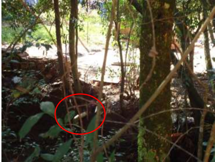
Figura 48 - Lançamento de esgoto direto em curso hídrico junto ao Arroio Max
