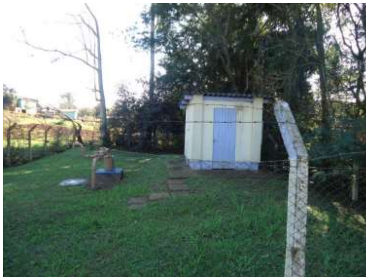
Figura 22 - Poço 06 localizado na Rua Amazonas
