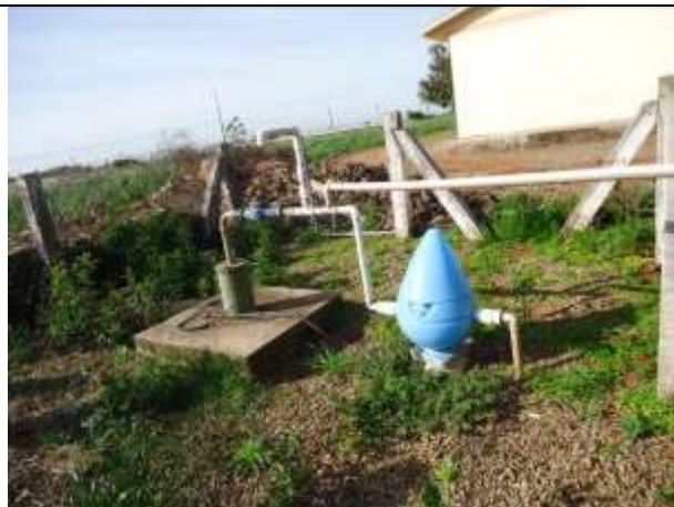
Figura 35- Tratamento no poço localizado no Lar do Idoso
