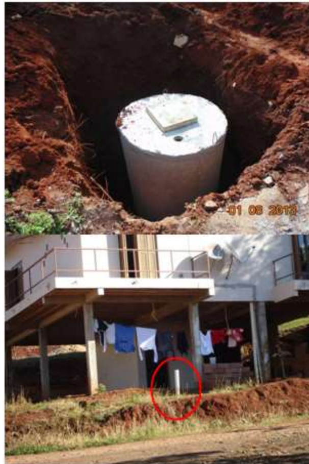
Figura 50 - Implantação de uma fossa-séptica no município e ponto de limpeza implantado junto a fossa ou aos poços negros.
