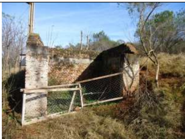
Figura 27 - Poço localizado na comunidade de Granja Luiza 2
